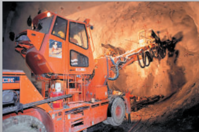
Sedrunin osuus on ruuhkeinen ja TBM-laitteita ei voi käyttää. Näin on turvauduttava perinteisempään systeemiin. Tamrockin porausjumbo poraa syvällä Alppien alla.
